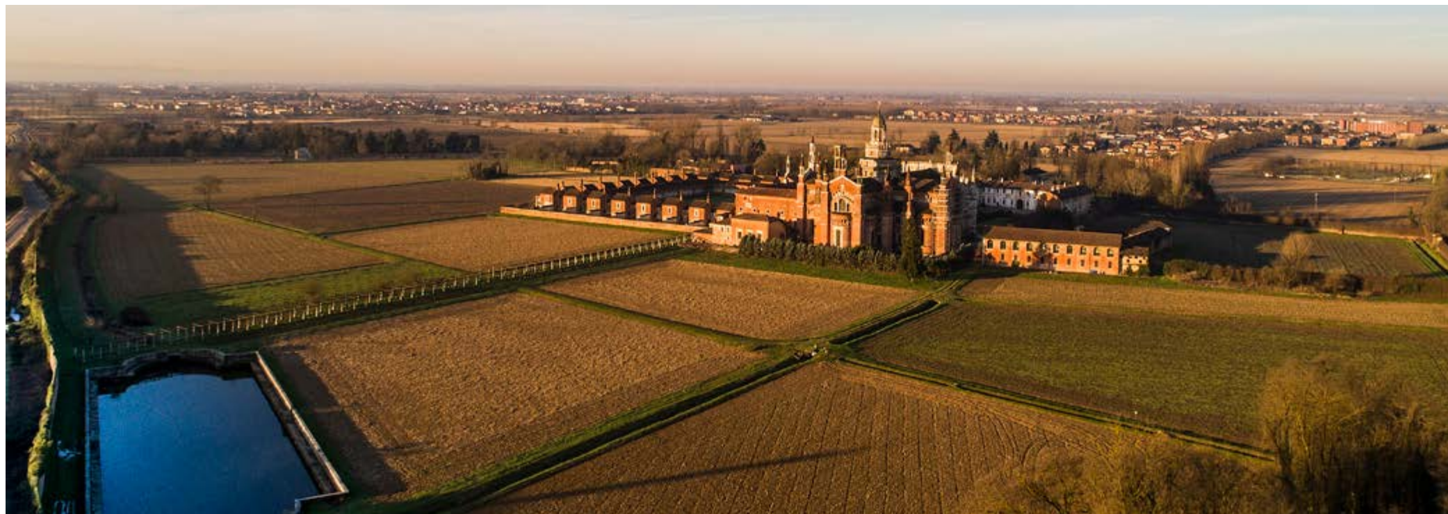
Photo. The monumental complex of Certosa di Pavia.
